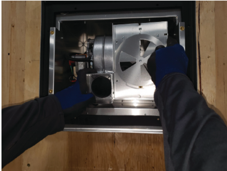
Figure 8.3 - Retrait de l'évacuateur
