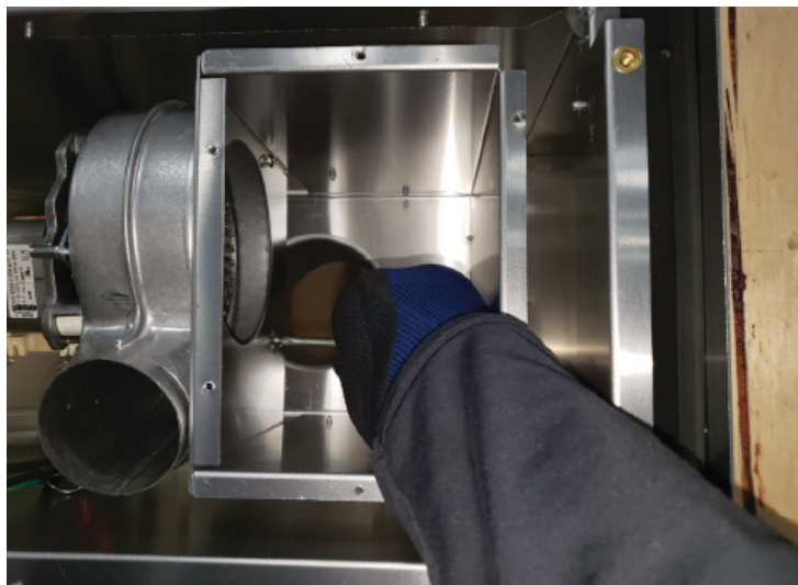
Figure 8.6 - Retirer les (3) vis retenant le ventilateur
