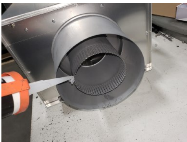
Figure 6.9 - Appliquer du silicone au conduit d'évacuation interne du Power Vent
