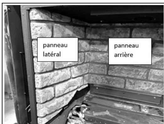
Figure 9.5, pose de panneaux réfractaires
