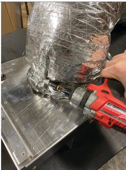
Figure 2.14, Revêtement installé avec collier de serrage
