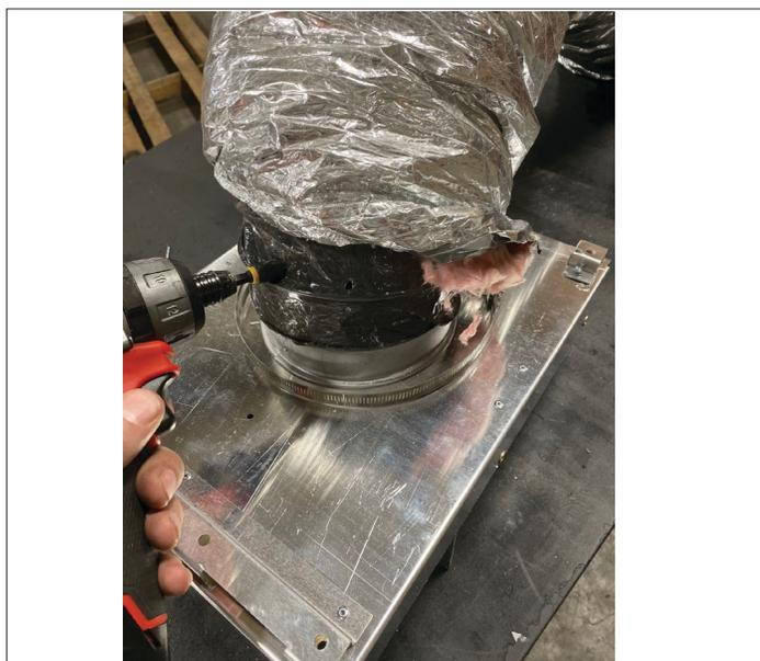
Figure 2.13, Vis dans le revêtement intérieur
