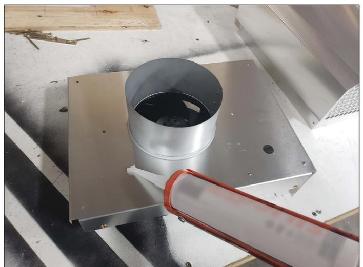
Figure 2.8, Appliquez le scellant silicone sur la face arrière
