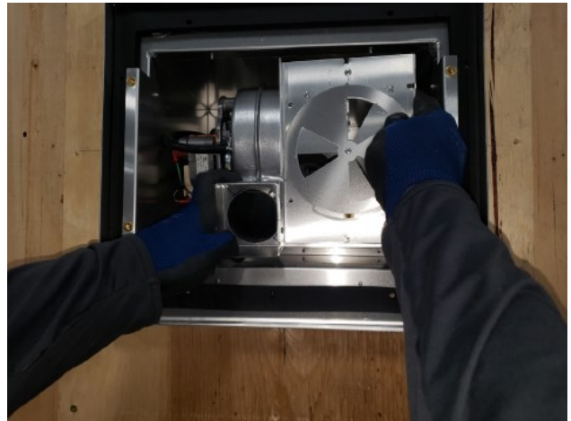
Figure 8.3 - Retrait de l'évacuateur
