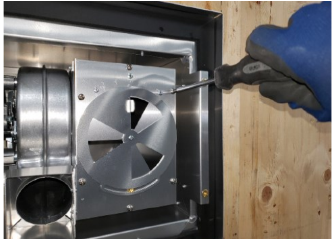
Figure 8.2 - Vis de l'évacuateur
